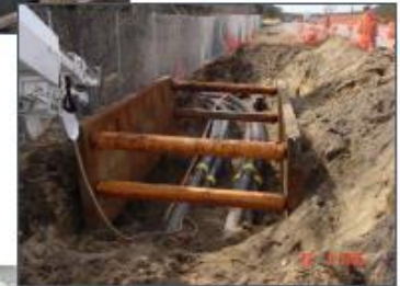
Conduit Installation
